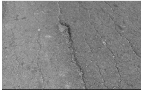
Fig:3. Longitudinal Cracking
